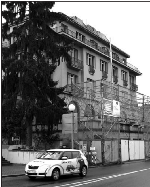
Alexandria I těchto dnů – horké staveniště
